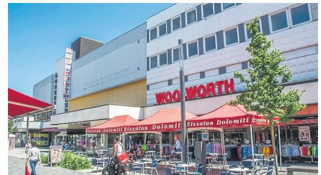
Das Woolworth-Gebäude in der Korbacher Fußgängerzone soll im Oktober 2020 abgerissen werden.
