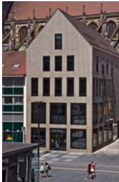
Den monolithischen Charakter des Hauses unterstreicht das Dach, das mit Tondachziegeln in der Farbe der Fassade eingedeckt wurde.
