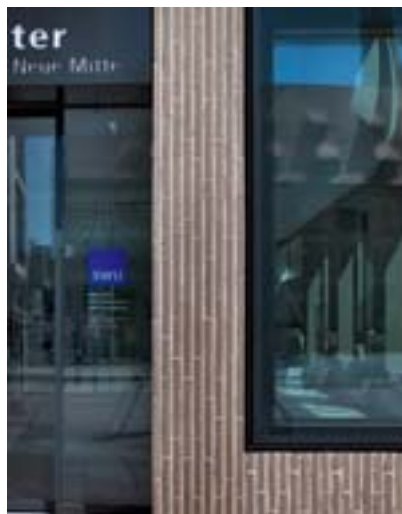
Senkrecht vermauerte Klinker im Riegelformat.
